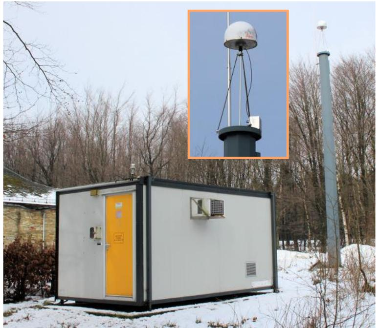
Double mât de 9 m portant l'antenne GPS (ULg) ; à gauche : conteneur TELERAD.
